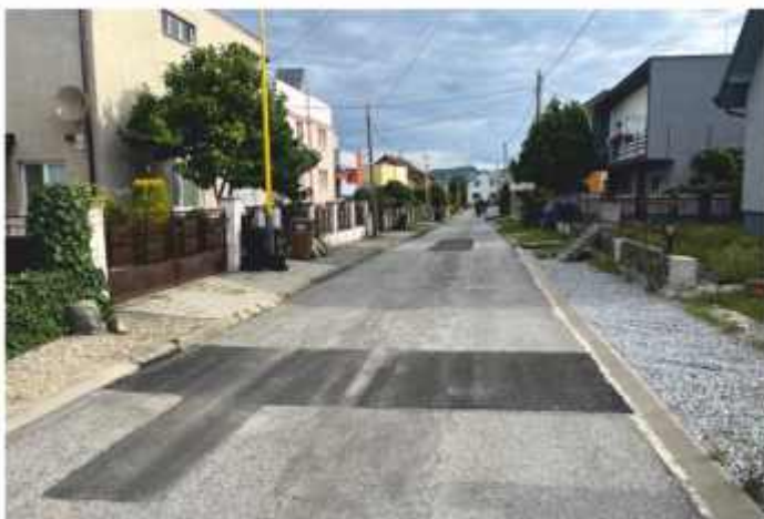
Pohľad na opravené miesta cesty na Trnkovej ulici. Foto: M. Bilý
